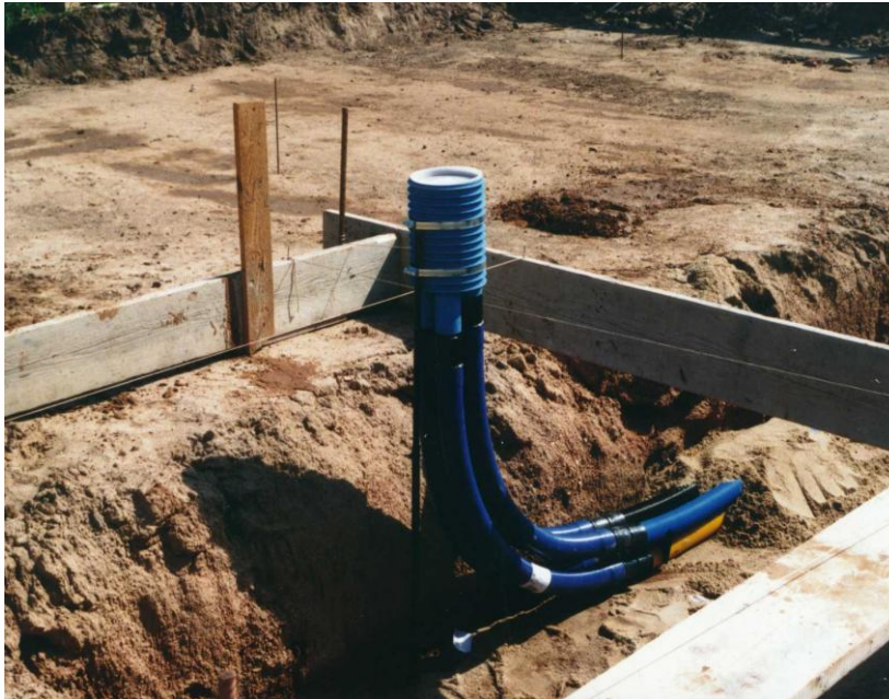
Mehrspartenhauseinführung am Schnurgerüst ausgerichtet
