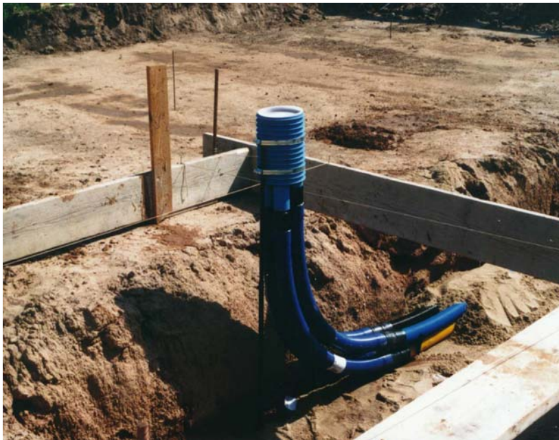
Mehrspartenhauseinführung am Schnurgerüst ausgerichtet
